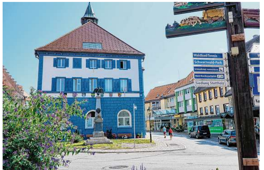
Auch von außen bietet das sanierte Löffinger Rathaus einen herrlichen Anblick. BILDER: GEROLD BÄCHLE
