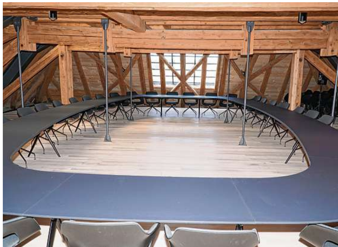
Der Sitzungssaal im Dachgeschoss stellt für die Verantwortlichen eine große Herausforderung dar: 40 Tonnen Stahl in Form von Streben stützen künftig die historische Dachkonstruktion.
