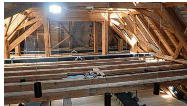
Die beeindruckende Dachkonstruktion direkt über dem Sitzungssaal ist verglast und lässt den Blick in den Sternenhimmel schweifen.
