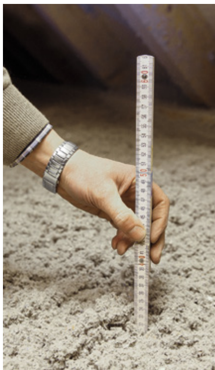
Ein Fachmann misst die Stärke einer Zellulose-Schicht auf dem Dachboden.
