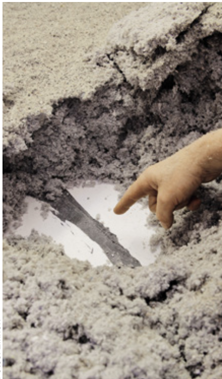
Vor dem Dämmen müssen Sie die Schlitzze in den Decken abdichten.
