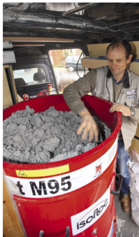
Im Bottich befindet sich die Zellulose, die vor dem Dämmen zerkleinert wird.
