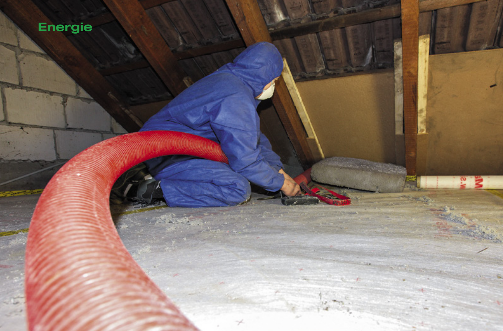
Ein Handwerker füllt die Schächte im Dach mit Zellulose. Der Einblasdämmstoff hat ähnlich gute Eigenschaften wie Mineralwolle.
