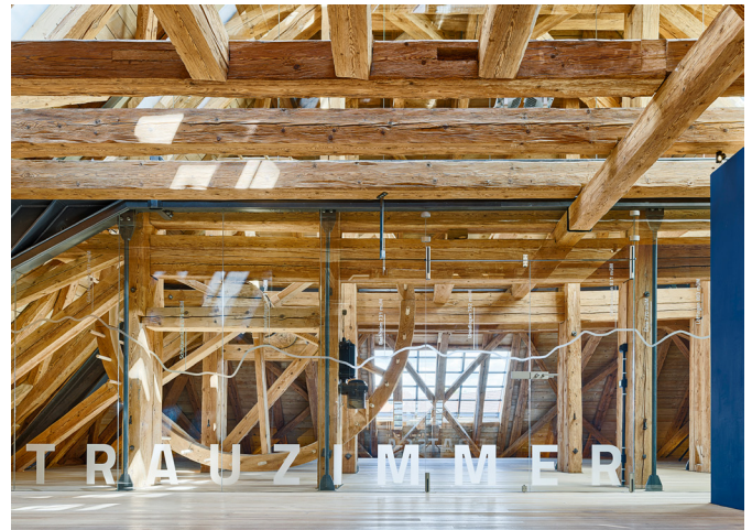
Neben dem großen Ratsaal beherbergt das Dachgeschoss auch das Trauzimmer der Stadt, das mit einer gläsernen Wand zwar akustisch, nicht aber optisch vom Rest abgetrennt ist.
