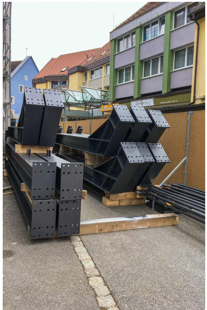
Etwa 30 Tonnen Stahl mussten im Dachgeschoss verbaut werden, was vor allem logistisch eine Herausforderung war. Montiert wurden die einzelnen Tragkonstruktionen erst vor Ort.
