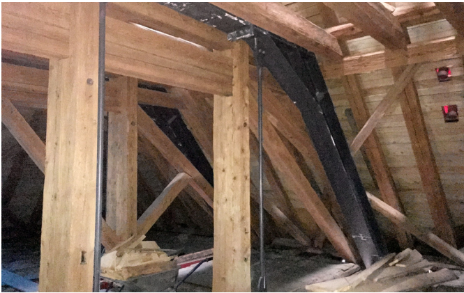
Über Zugstäbe und die tragenden Stahlbrücken wurden die Lasten der neuen obersten Geschossdecke auf die Außenwände abgeleitet.
