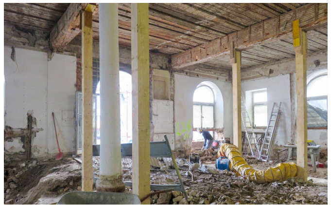
Nachdem alle störenden Zwischenwände im Erdgeschoss rausgerissen waren, kam der großzügige Charakter der ursprünglichen alten Markthalle wieder zum Vorschein.
