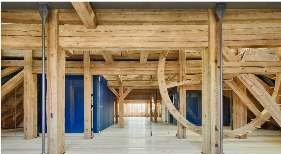
Auch das Blau der in Trockenbauweise erstellten und im Dachgeschoss eingestellten Boxen für die Toiletten und die Teeküche ist kein Zufall, sondern entspricht dem Blau des Stadtwappens.
