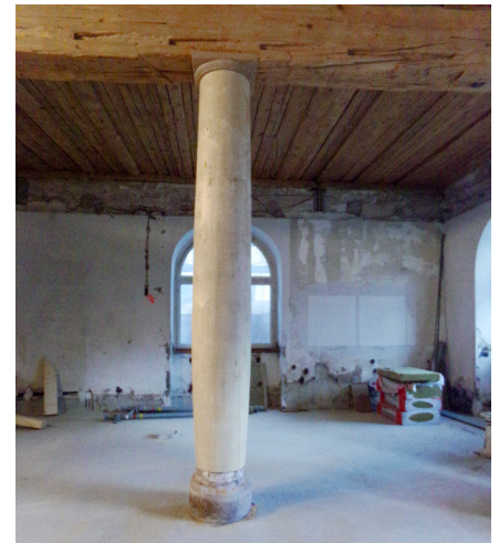
Die massiven Holzsäulen, die zu ersetzen waren, wurden aus einem einzigen Tannenstamm gedrechselt. Das Holz dazu stammt aus dem stadteigenen Wald.
