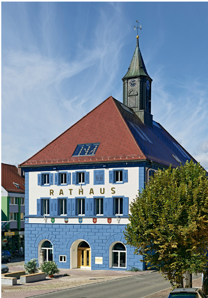
Das etwa 190 Jahre alte Rathaus steht im Zentrum des Schwarzwaldstädtchens Löfzingen. Seit der Sanierung erstrahlt das Gebäude im Blauton des Stadtwappens.
